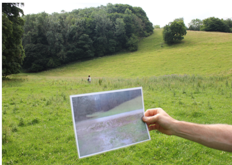
Alacsony, füvesített földszánc lejtős legelőn, a fotón a nagy eső utáni állapot (© Farkas Viktor Mátyás)
