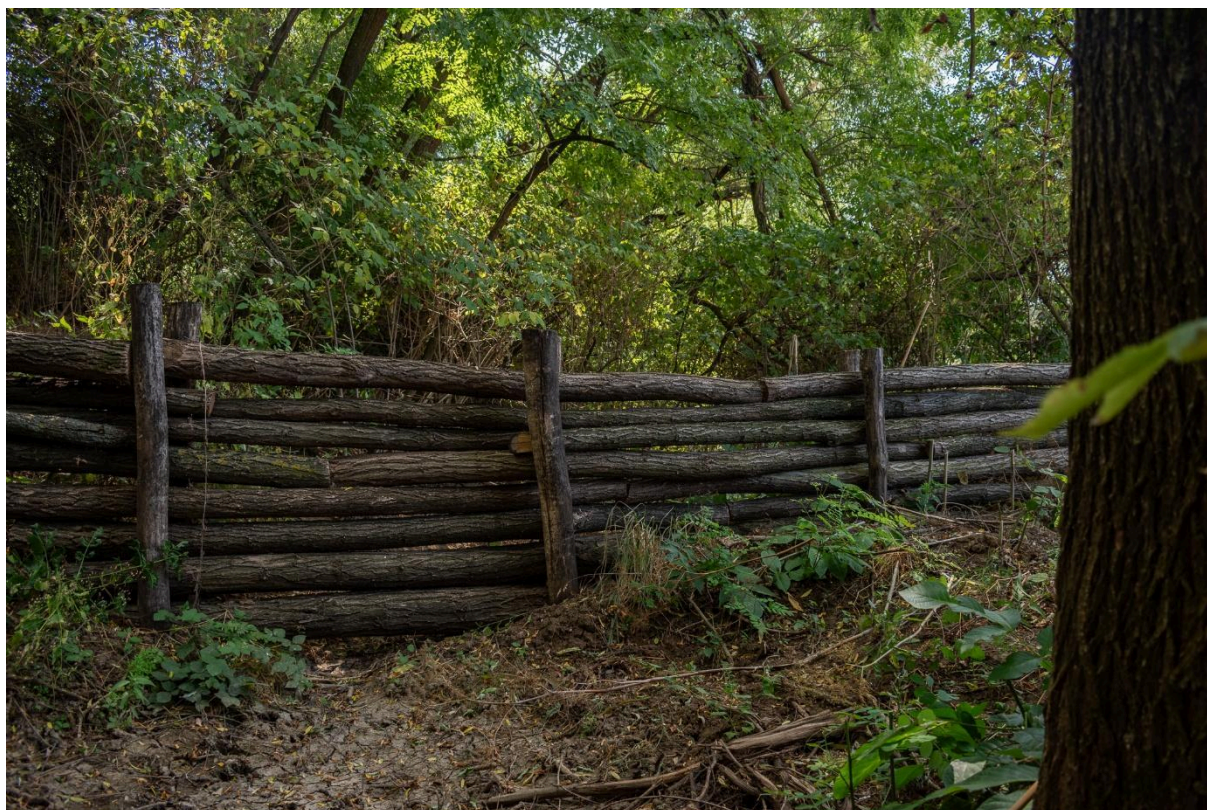
15. ábra Kisémedi Némedi-patak egysoros rönggát
