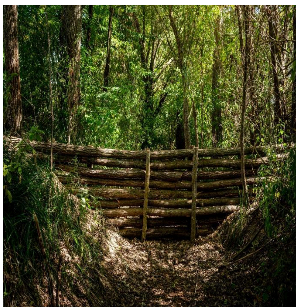
7. ábra Penc Szirota helyszínén kihelyezett rönkgátak
