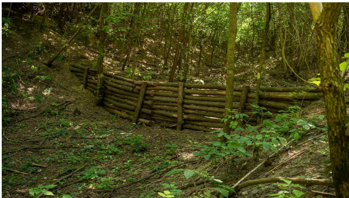
14. ábra Váckisújfalu Új telep II. rönggát
