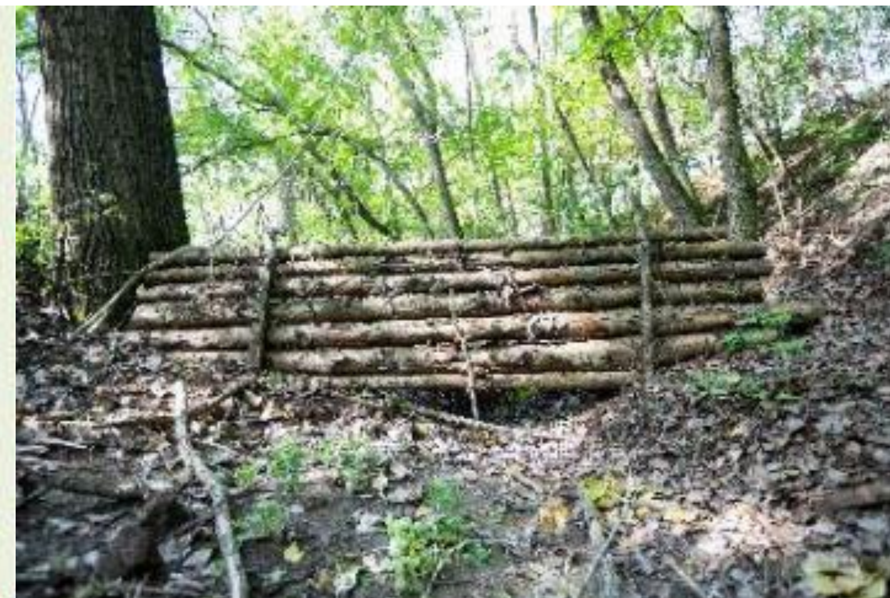
Lefolyáslassítás szivargó rönkgátakkal
