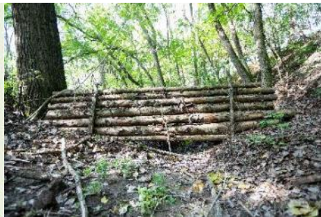
Lefolyáslassítás szivárgó rönkgáttakkal
