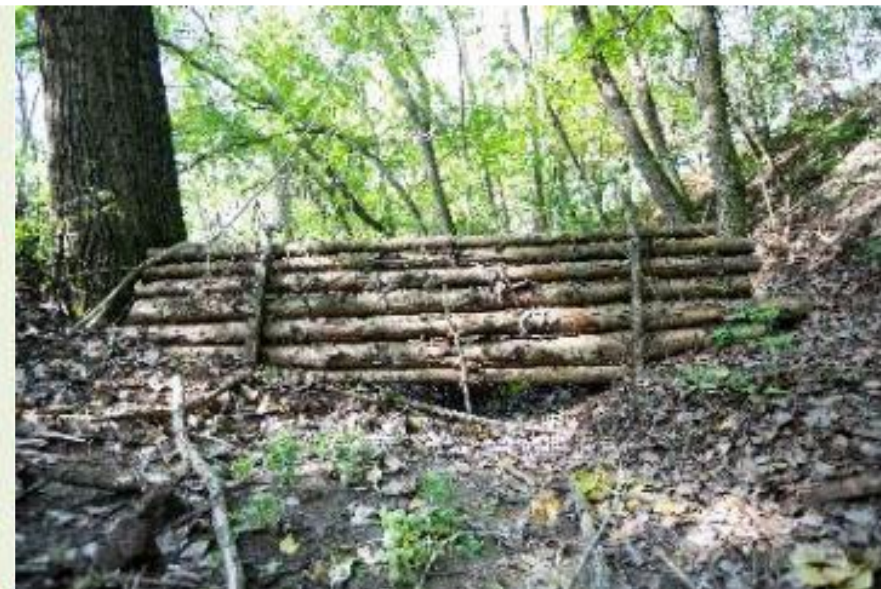
Lefolyáslassítás szivárgó rönkgátakkal
