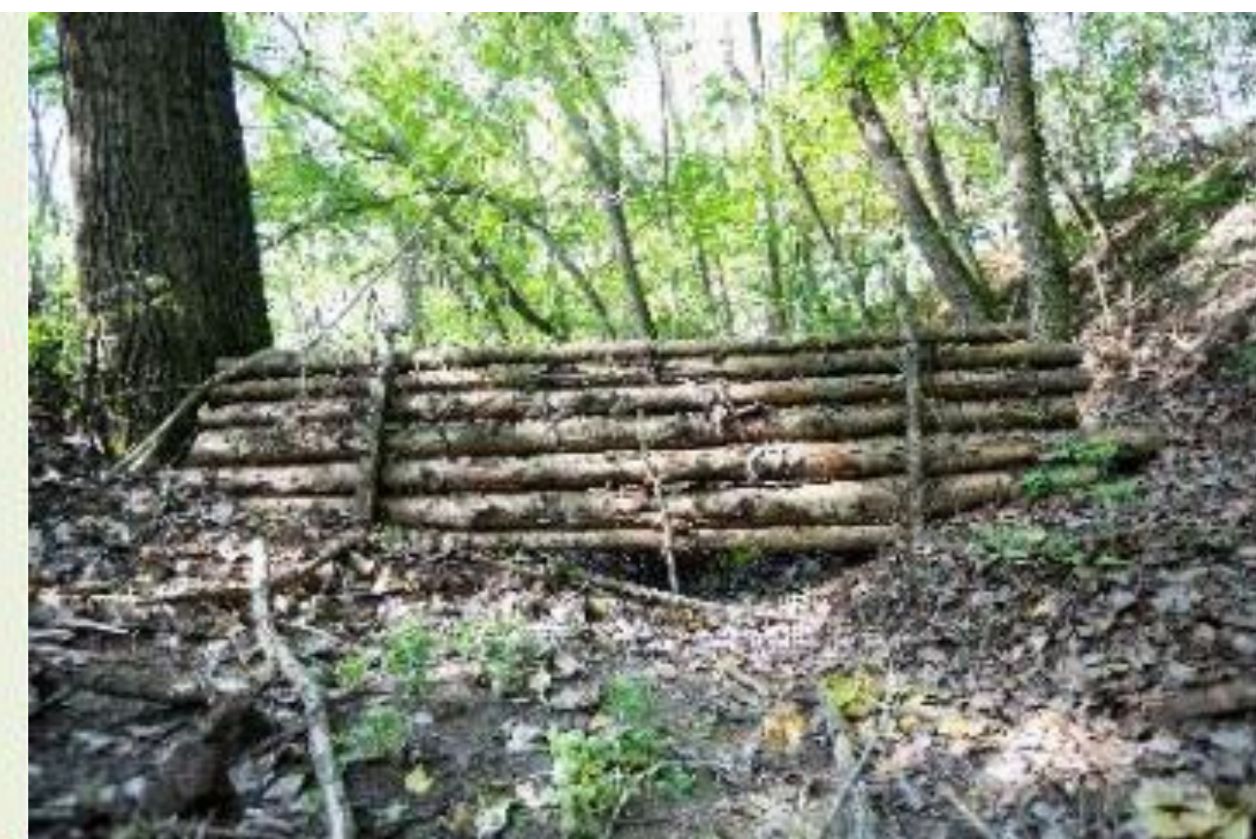
Lefolyáslassítás szivárgó rönkgátakkal
