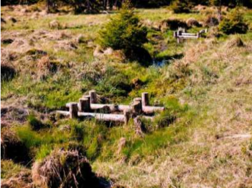
Lecspoló csatornák elzárása a Szklarska Poręba erdészetnél
