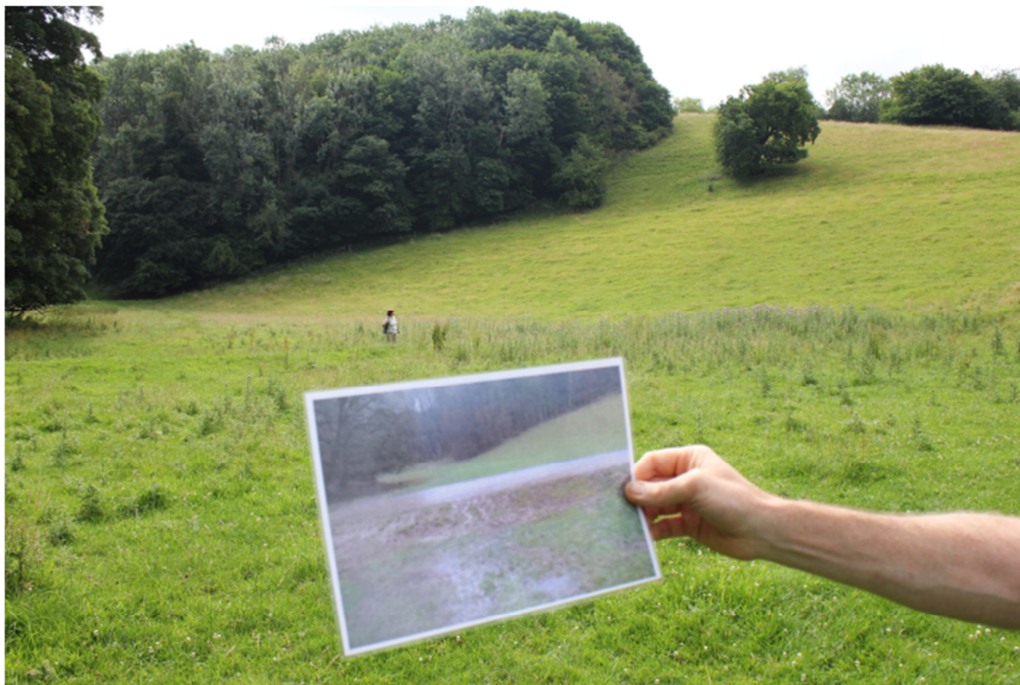
Alacsony, füvesített földszanc lejtős legelőn, a fotón a nagy eső utáni állapot (© Farkas Viktor Mátyás)
